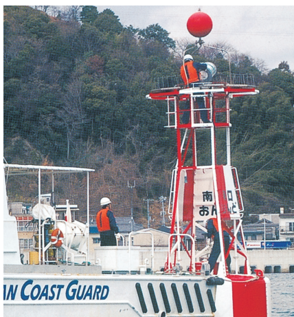
灯台の点検・整備
