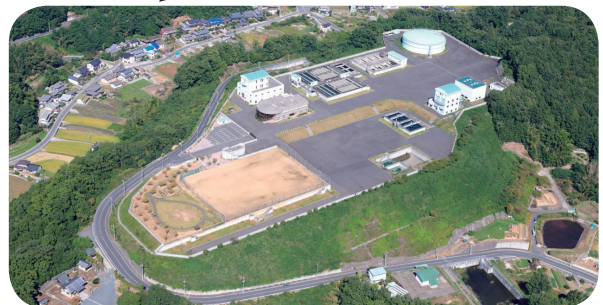
せんだじょうすいじょう 〔千田浄水場〕
