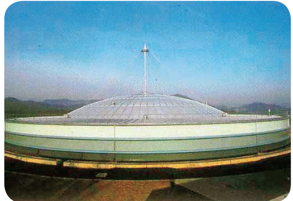
せんだはいすいち 〔千田配水池〕
