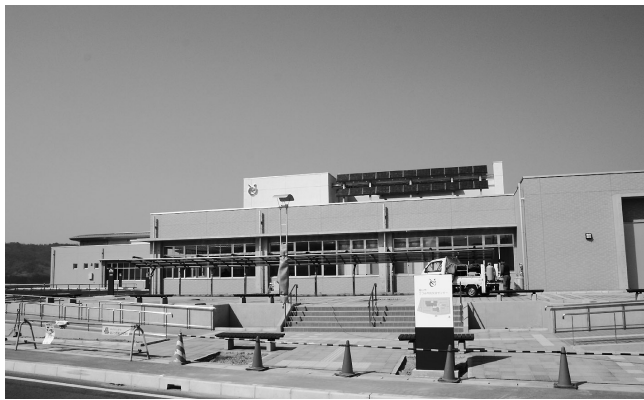
建築中のうつみ市民交流センター
