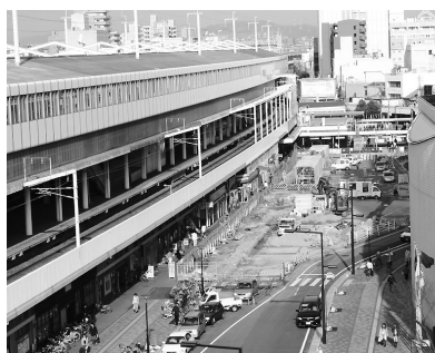
▲7月1日オープン予定の自転車地下駐車場
