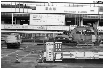
整備が進む福山駅前
