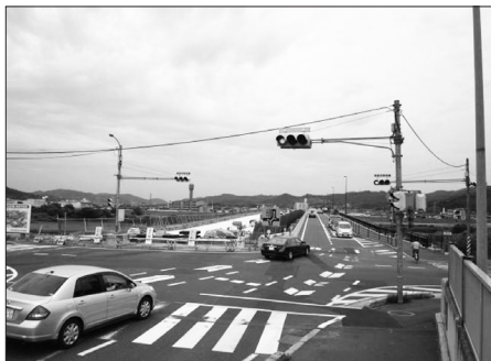
工事中の山手橋
