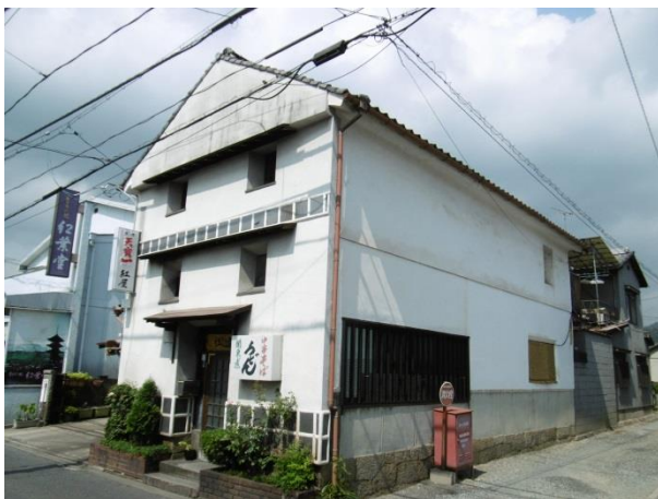
土蔵を店舗として再生・活用
