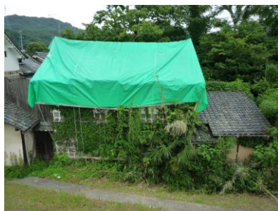
米蔵（シートによる養生）
