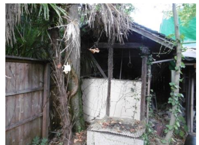
米搗小屋・物置・便所
