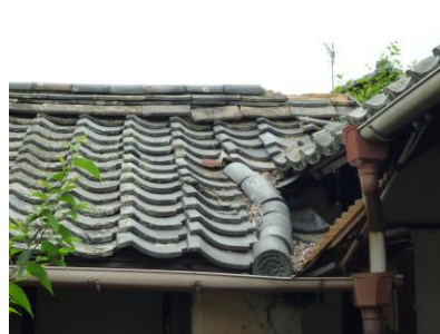
寮舎屋根の劣化（瓦崩落）
