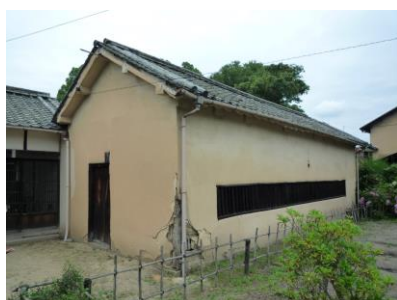
寮舎全景（壁面の崩落）
