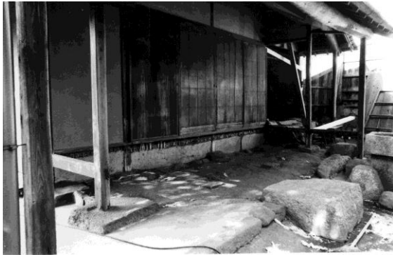
廉塾竹縁解体
