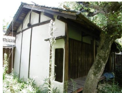
祠堂（シートによる養生）
