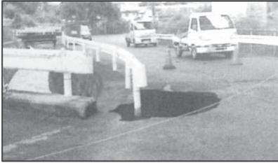
〈7月の大雨による道路の陥没〉
