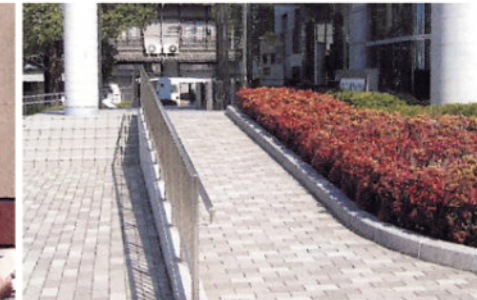
車いす利用者も安心して利用できるスロープ
