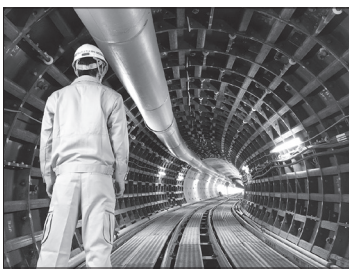
雨水幹線の整備 (抜本的な浸水対策の取り組み)
