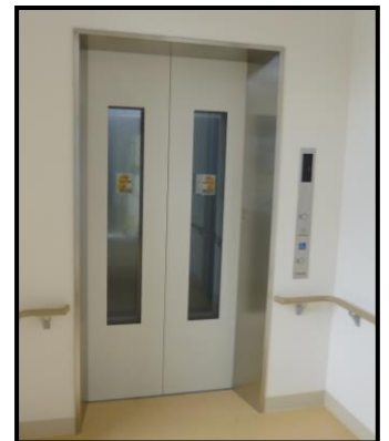
エレベーター
