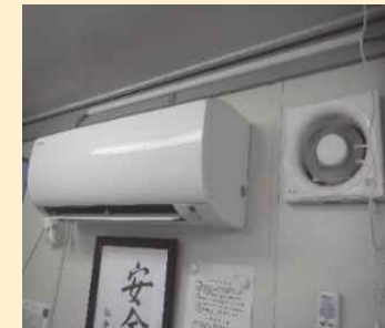
扇風機や換気扇とエアコンを併用
