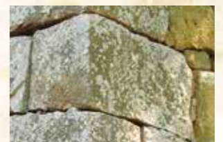
加工した石垣
