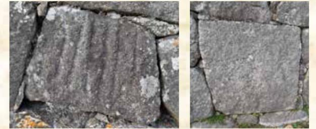
伏見櫓下の写真を比べてみてください。表面の加工の加減が違います。簡単に言えば、右の平面の石垣は石垣加工のプロがやったものです。左の石垣は力の強い若者が加工したものだと考えられます。
