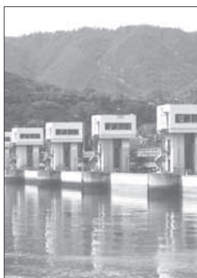
耐震化が急がれる河口堰
