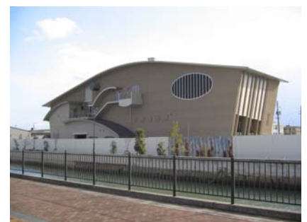
中央ポンプ場
