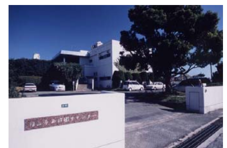
松永し尿処理場
