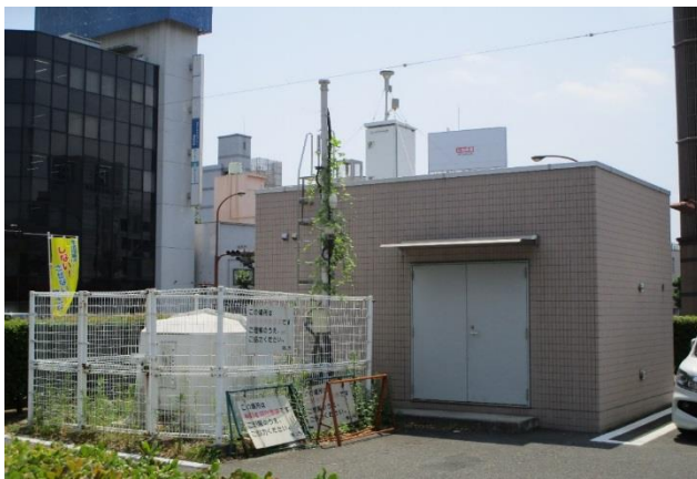
大気汚染常時監視測定局舎(市役所・自排局)
