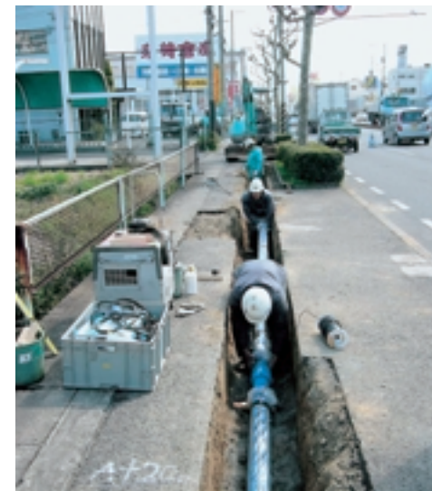
水道管の耐震化
