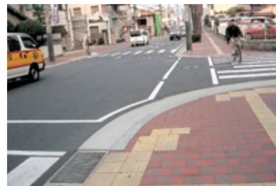
段差をなくし安全性に配慮した生活道路
