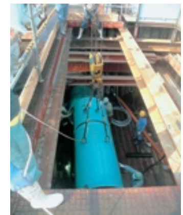
下水道幹線埋設工事
