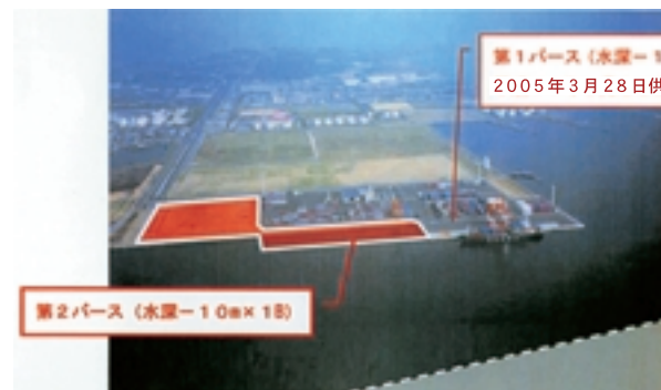
福山港箕沖地区国際コンテナターミナル整備
