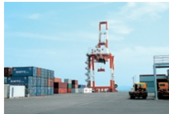
福山港箕沖地区国際コンテナターミナル第1バース
