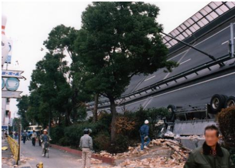
神戸市東灘区深江本町（阪神高速倒壊現場）
