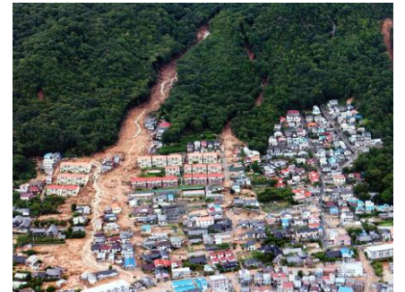
広島市安佐南区八木 （土石流家屋倒壊現場）
