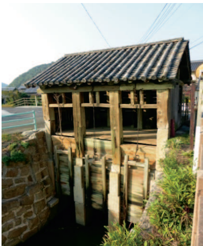
南側市道から見た唐樋門
