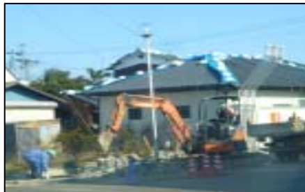
まちのいたるところで復旧作業が行われている。
