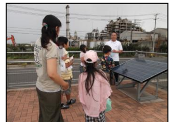
メガソーラー発電所
