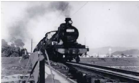
福塩線 神谷川鉄橋と蒸気機関車 1957年（昭和32年）頃の撮影
