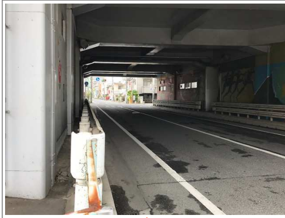
エフピコRiM北東角の交差点から北方向を撮影
