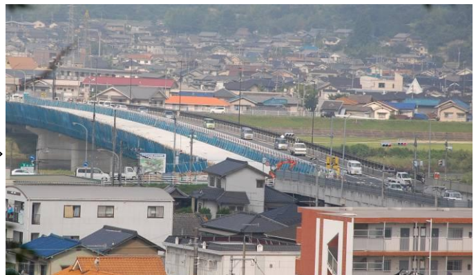
【床版工事施工中】
