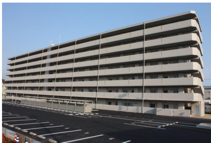
【深津市営住宅1号棟】
