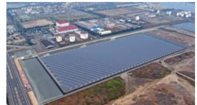
【福山太陽光発電所（メガソーラー）】 出典 中国電力（株）
