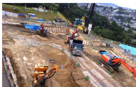
【地盤アンカー工事(地下部分)】
