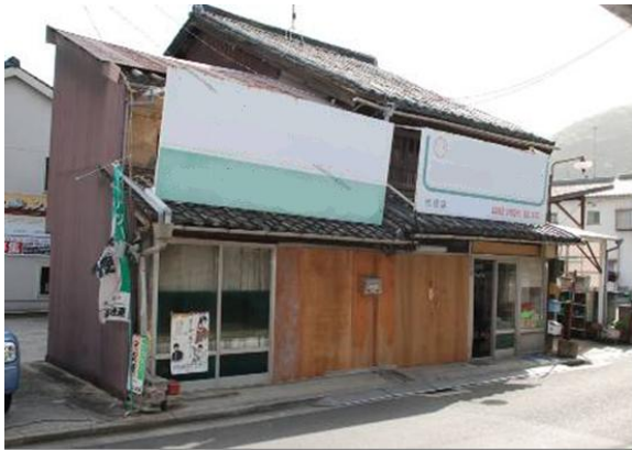
【修理前…建物全体が老朽化】
