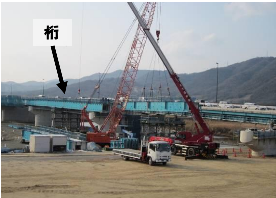
【桁架設工事中】
