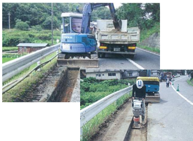
【水道管の布設工事】
