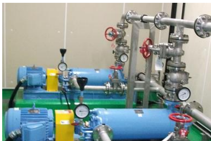
【送水ポンプの設置】
