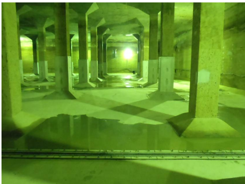
【木之庄配水池】
