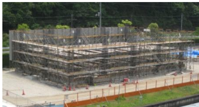
【管理棟築造工事】
