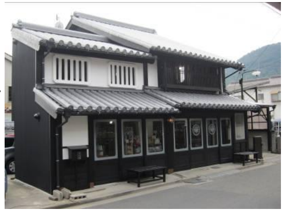
【修理後…屋根瓦，壁など全体をきれいに修理】
