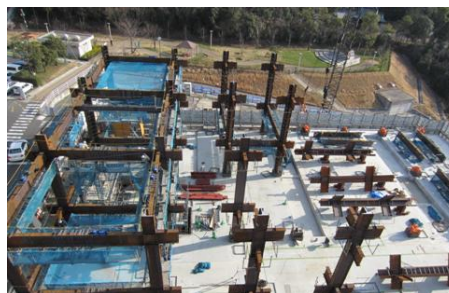
【高層棟鉄骨建て方(1～2階部分)】
