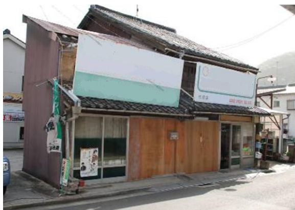
【修理前…建物全体が老朽化】
