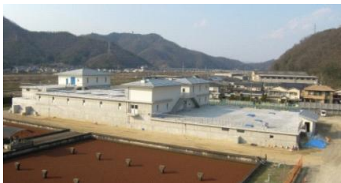
【急速ろ過池築造工事】
