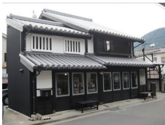
【修理後…屋根瓦, 壁など全体をきれいに修理】
