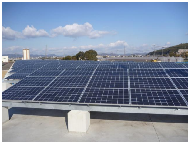
【箕島浄水場太陽光発電設備】
