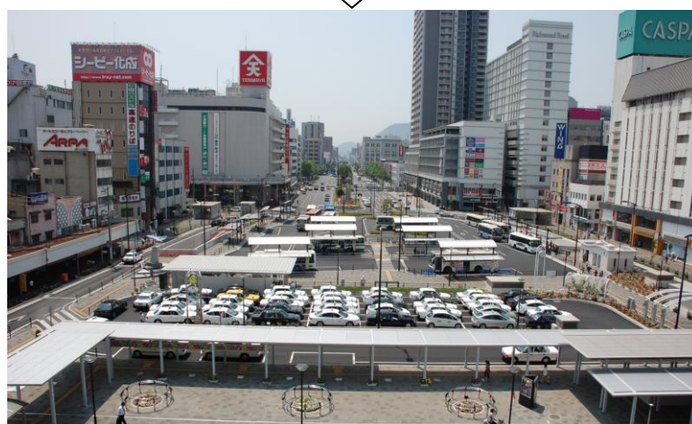
【福山駅前広場整備後(2012年(平成24年)撮影)】
