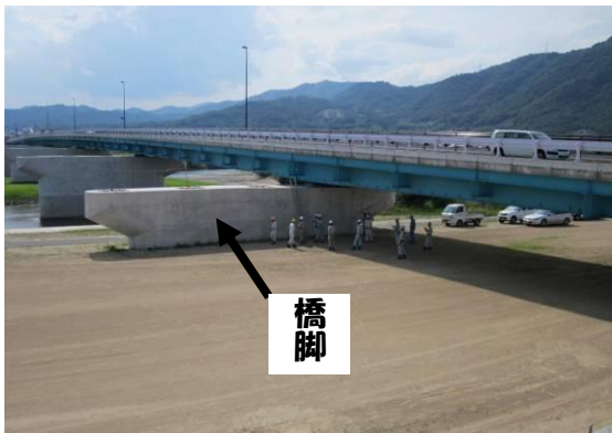
【橋脚工事完成】
