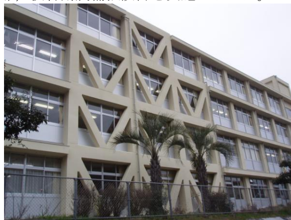
【向丘中学校南棟耐震補強工事】
