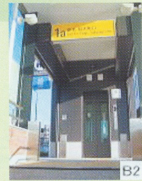
エレベーターの設置
