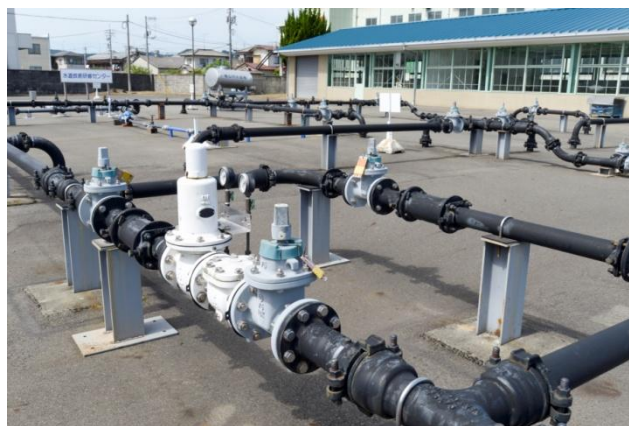
水道技術研修センター（福山市山手町）
