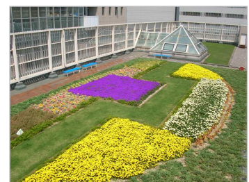
屋上緑化（市役所本庁会議棟）
