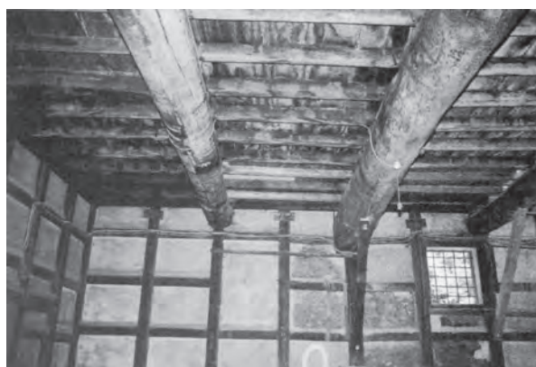
106へ 住宅（土蔵右側）梁組
