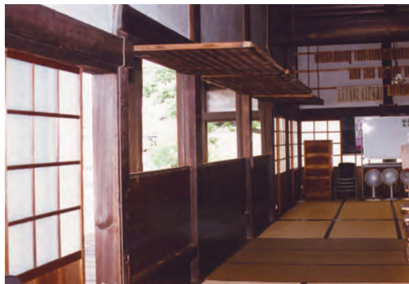
写真94 本堂外陣正面部
