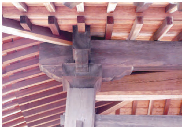
写真114 鐘楼大斗実肘木
