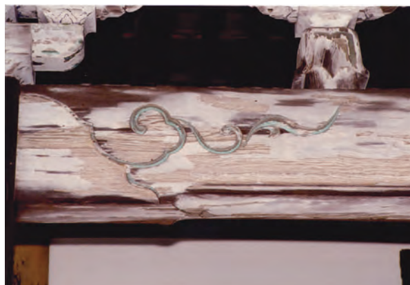
写真125 本堂向拝虹梁形頭貫
