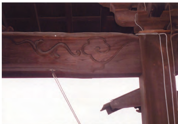
写真97 本堂向拝虹梁形頭貫
