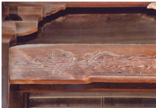
写真41 渡守神社本殿庇虹梁形頭貫
