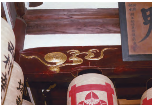
写真75 本堂外陣虹梁形飛貫
