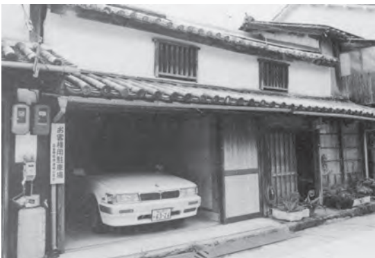
41・42 車庫・住宅全景
