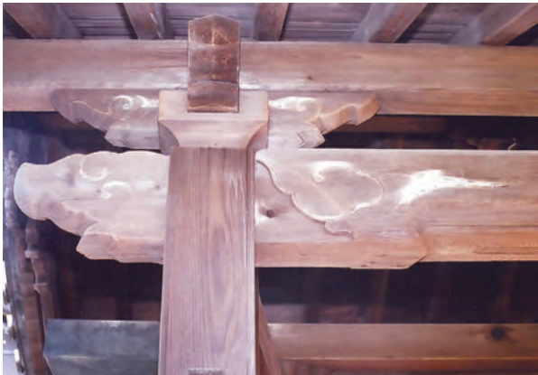
写真20 山門虹梁形頭貫・木鼻・大斗実肘木
