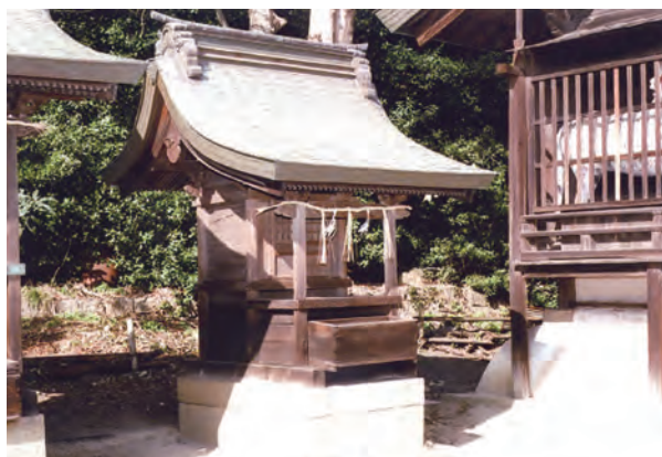
写真47 巖島神社本殿
