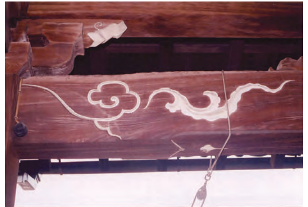
写真68 本堂向拝虹梁形頭貫
