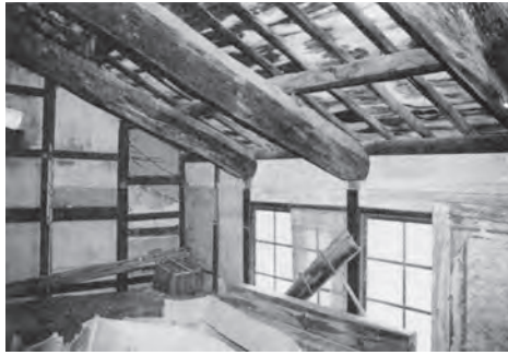
30 住宅二階内部
