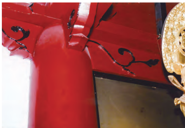
写真153 本堂来迎柱虹梁形頭貫
