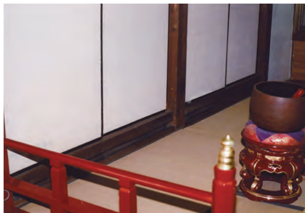
写真152 本堂内中敷居
