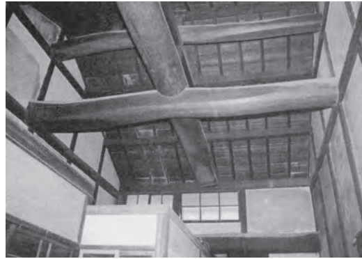
104 住宅 (主屋) 小屋組
