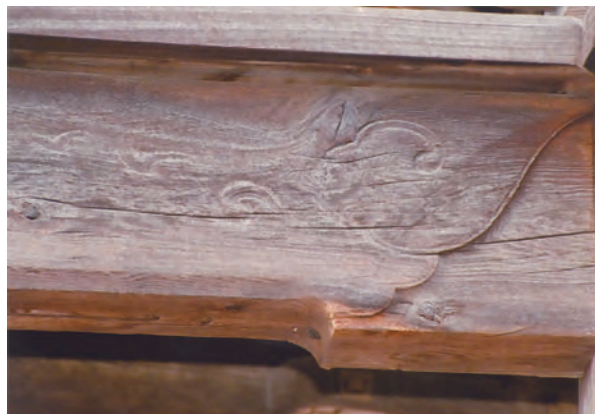
写真108 本堂向拝虹梁形頭貫
