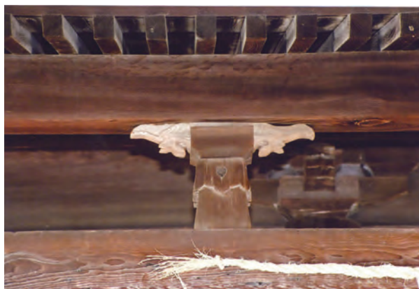
写真43 渡守神社本殿庇蓑束
