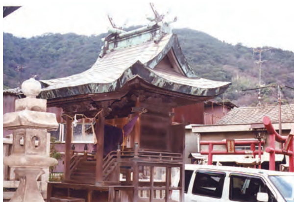
写真33 天目一箇神社本殿
