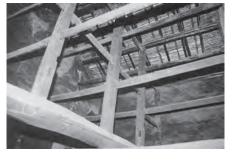
35は 倉庫 (右側) 小屋組
