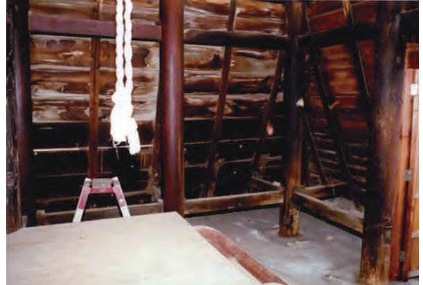
写真142 鐘楼下層内部
