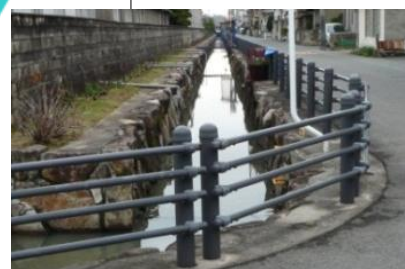
⑤きれいに整備された水路
