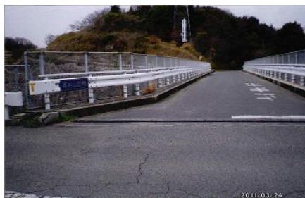
②高岩公園橋
