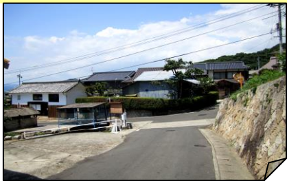
④南ゴミスーテーション横の三叉路東側
