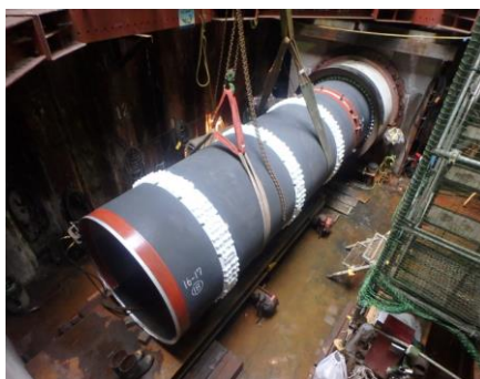
配水管布設工事
