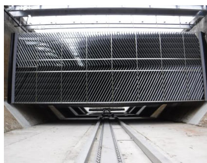
中津原浄水場設備取替工事
