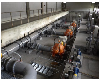
箕島浄水場送水ポンプ吸込管布設工事
