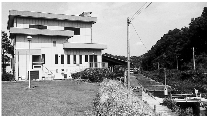
千田ポンプ場
