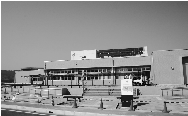
建築中のうつみ市民交流センター
