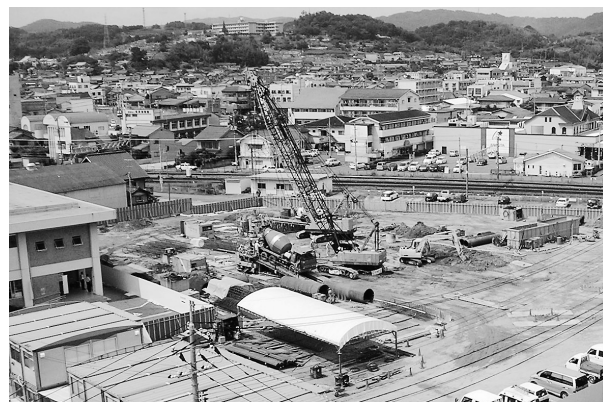
(仮称)西部市民センター建設工事の様子
