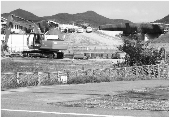
一般国道2号笠岡バイパスの工事の様子
