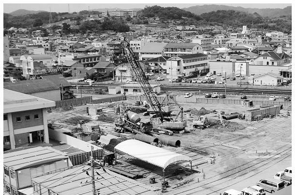
(仮称)西部市民センター建設工事の様子
