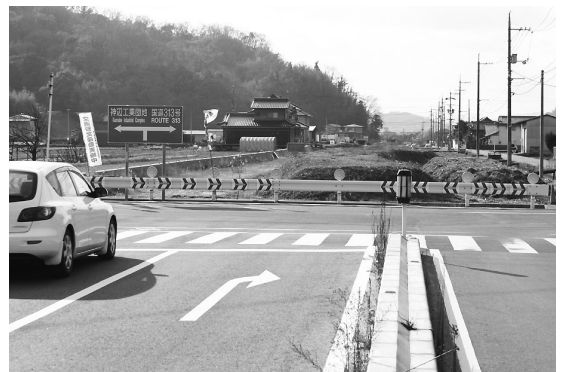
早期開通が望まれる国道313号バイパス
