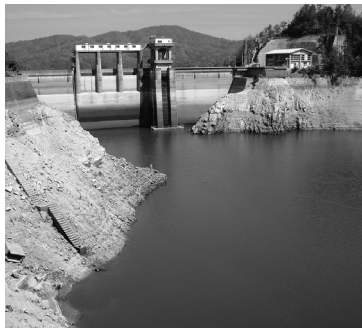
貯水位が低下した三川ダム
