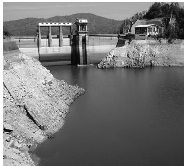
貯水位が低下した三川ダム
