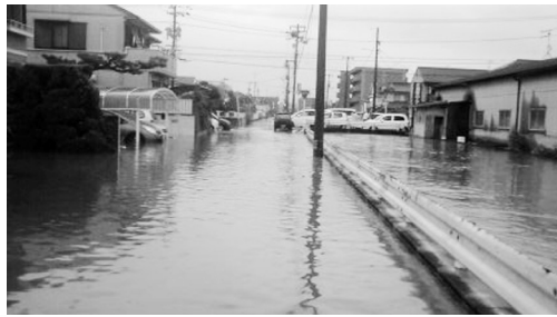
2008年の道路冠水被害
