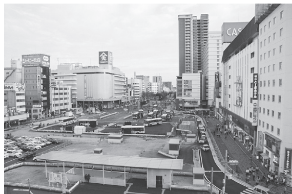
駅前広場の整備が進む福山駅南口
