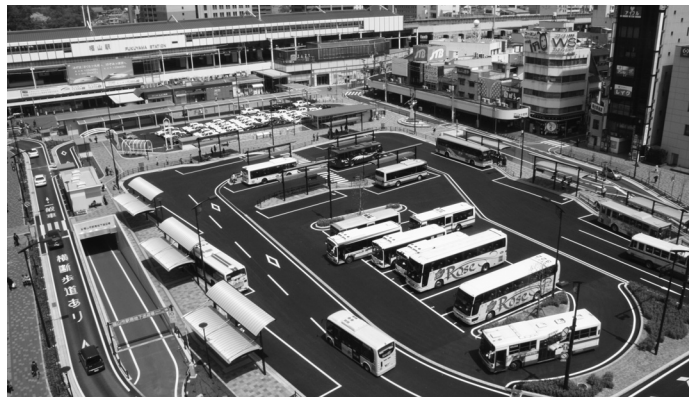
整備事業が完了した福山駅前広場
