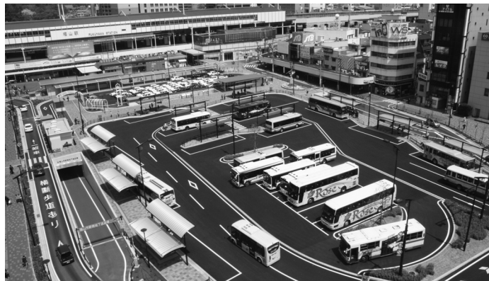
整備事業が完了した福山駅前広場
