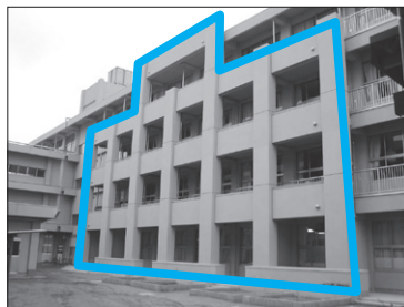
耐震化が完了した曙小学校北棟校舎 （太枠の部分が耐震補強箇所）
