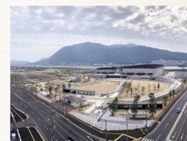
総合体育館建設地
