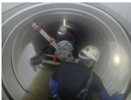
下水道施設の耐震化 ※既設管の中に、地震に強い管を新しく造る
