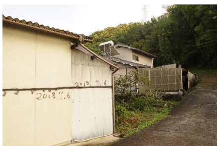
防災の記録（平成30年水位の記録）
