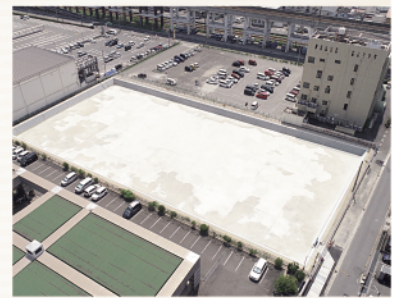
雨水貯留施設の整備
