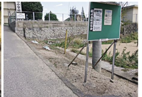
整備前の様子
