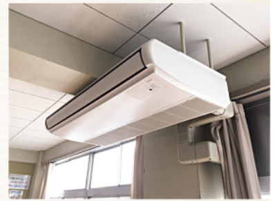
空調設備の整備
