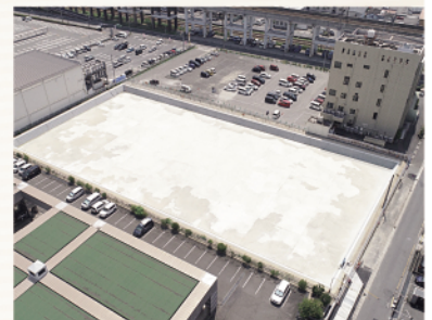
雨水貯留施設の整備
